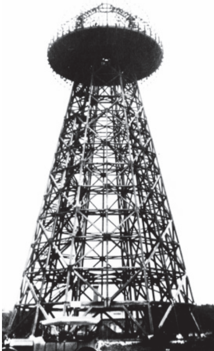
Der Sendeturm in Wardenclyffe zur drahtlosen Übertragung von elektrischer Energie.
